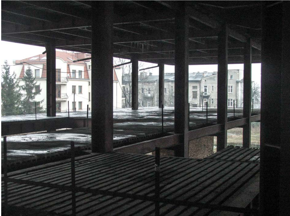
Jedna z pierwszych kondygnacji wieżowca (fot. Damian Dziura)
