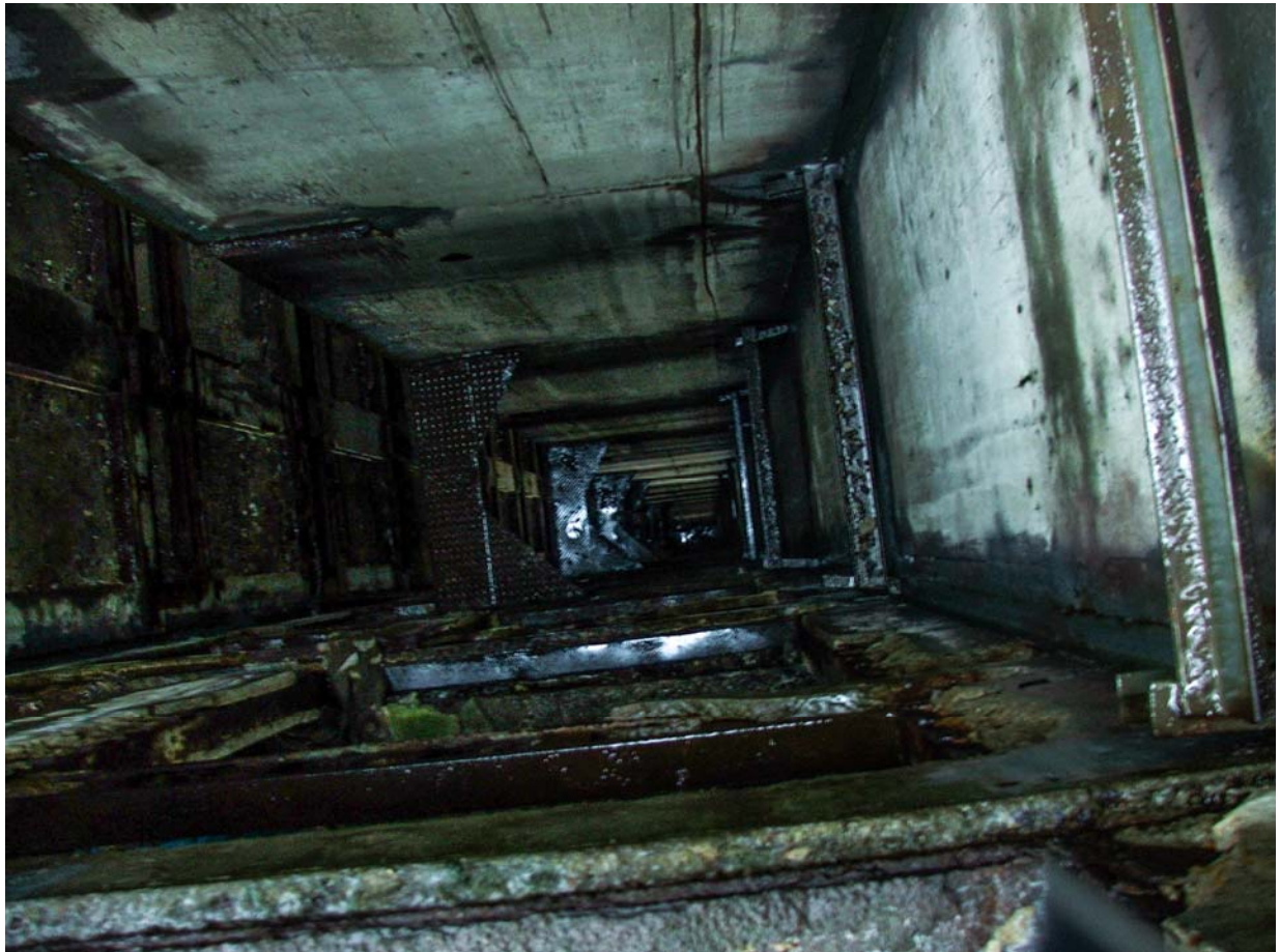
Szyb windy widziany z ostatniego piętra (fot. Damian Dziura)
