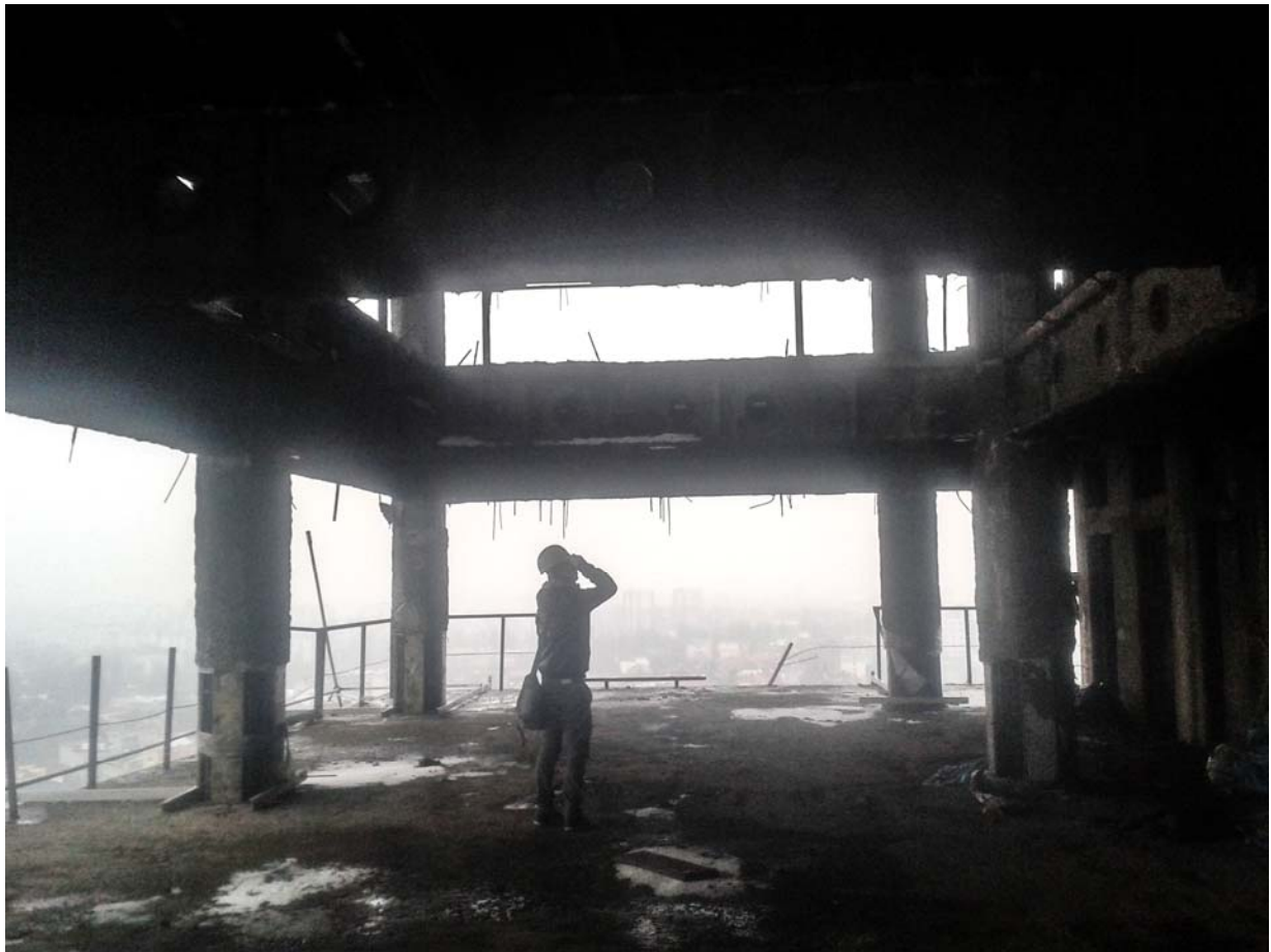
Wnętrze budynku (fot. Mateusz Witkowski)
