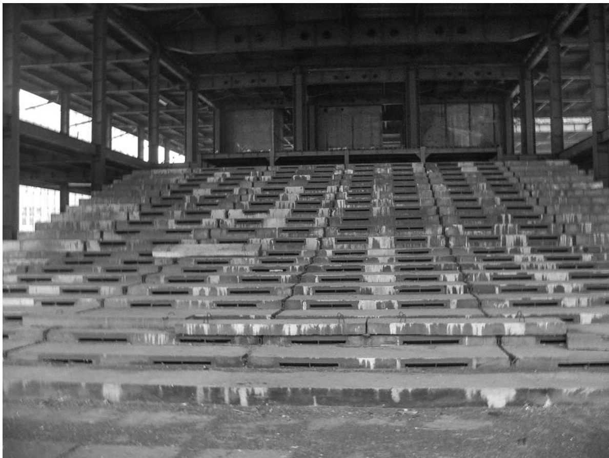
Schody u podnóża budynku (fot. Damian Dziura)
